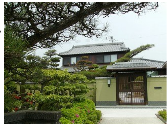
門も完成し、より風格のある外観
